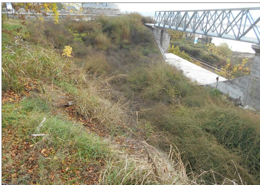
Foto 2. Gully erosion of Tăbăcarilor
